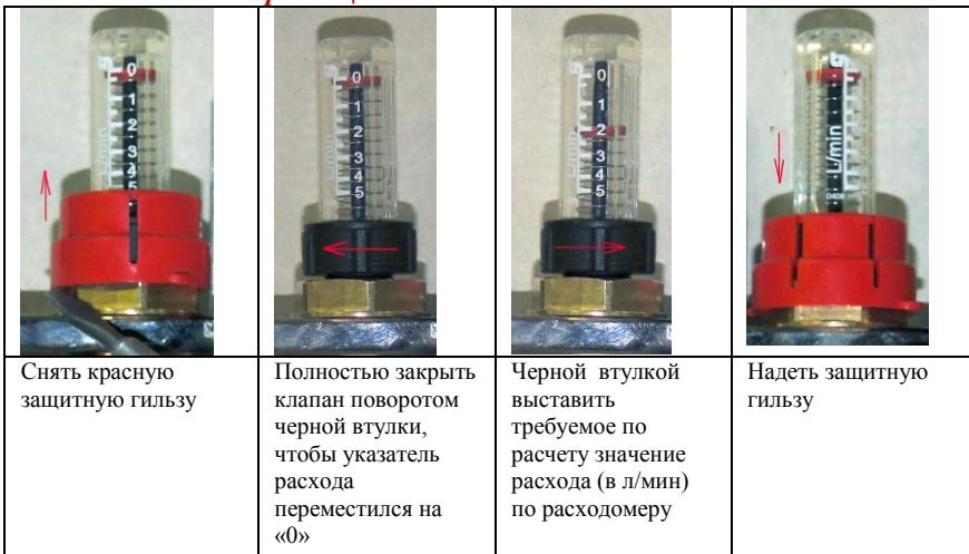
Снять красную защитную гильзу
