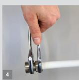
Вставьте трубу до упора и привинтите вручную гайку до упора. С помощью шестигранного гаечного ключа завинтите гайку до указанного в Таблице 3 числа оборотов.
