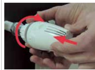
Установите термостатическую головку в положение максимального открытия.
