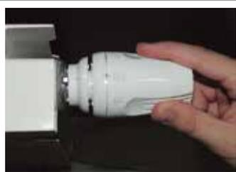
Установить желаемые температурные параметры, вращением ручки термоголовки.
