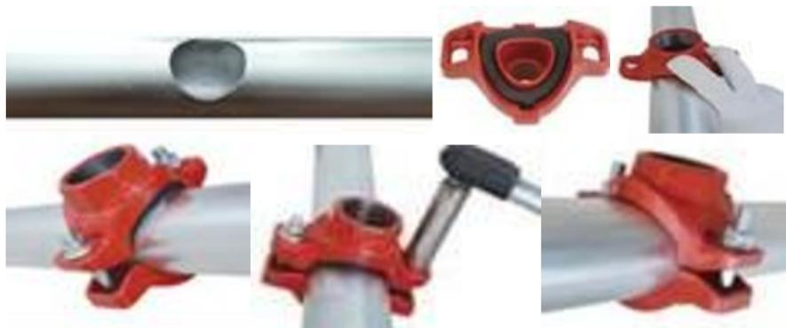
Рис.3. Установка отвода (седелка) под резьбу на трубопровод.
