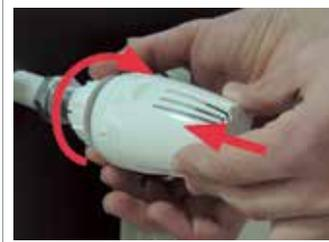
Установите термостатическую головку в положение максимального открытия.
