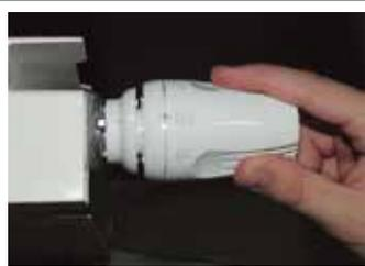
Установить желаемые температурные параметры, вращением ручки термоголовки.
