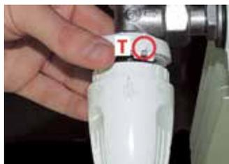
Поверните ограничительное кольцо. При помощи контрольной метки «Т» (см. рис.), которая служит ориентиром для правильного совмещения деталей, присоедините ограничительное кольцо, совмещая его с одной из трех пиктограмм, нанесенных на заднюю поверхность ручки:
